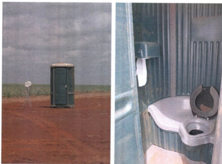
Fotos 33 e 34 – Instalações sanitárias provisórias nas frentes de serviço.
