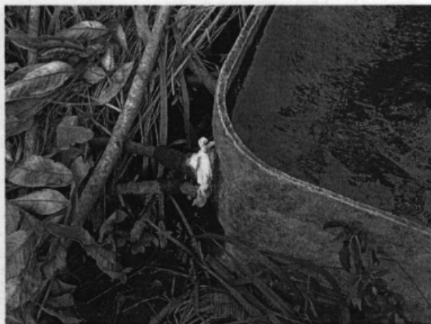
Na imagem à esquerda (foto 24), a detalhe das saídas de água da caixa d'água. Na imagem à direita (foto 25), cano de borracha que leva água para casas da fazenda desconectado no meio do pasto
