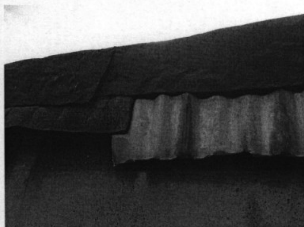
Casa 1. Na imagem da direita (foto 3), detalhe das placas metálicas improvisando vedação no telhado. Na imagem da direita (foto 4), saída do encanamento da água do chuveiro.
