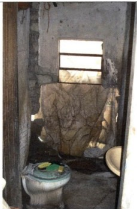
Banheiro utilizado pelos trabalhadores, a pia não tem água, a água do chuveiro é fria (conforme declarado) e a parede abaixo da janela caiu, e o buraco estava coberto com saco plástico.
