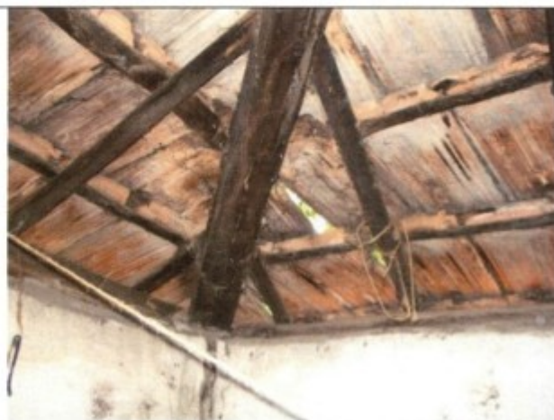
Telhado com fendas e rachadura na parede
