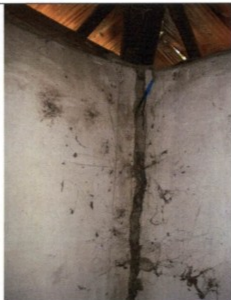
Trincas na parede do alojamento e sujeira
