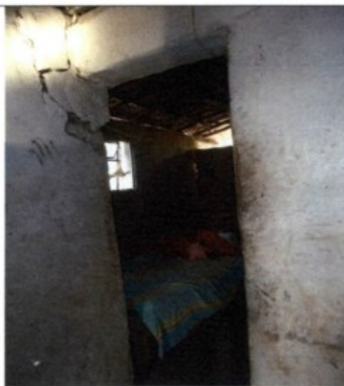
Estrutura comprometida, janela sem vidros, a parede não chega até o telhado.
