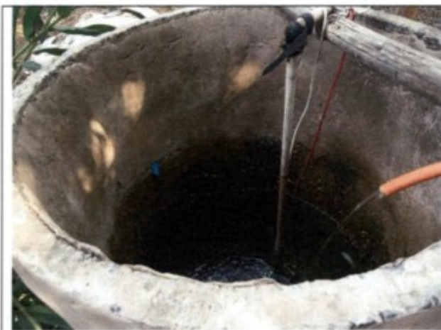
Água utilizada pelos trabalhadores do alojamento abaixo da Sede, da Sede (casa de madeira) e refeitório. O reservatório não possuía tampa e a água vinha encanada da vereda até este reservatório, sendo consumida sem passar por qualquer tipo de tratamento.
