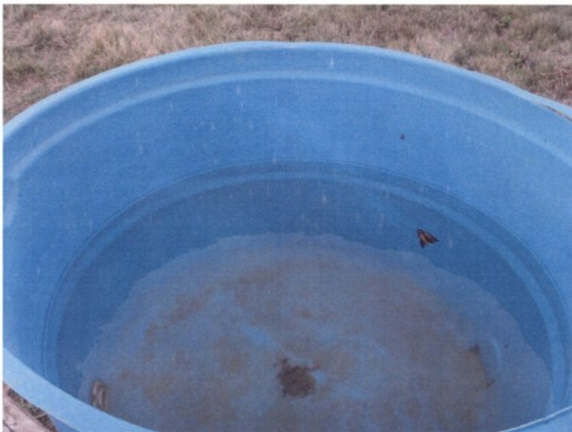
Tanque de caixa d'água usado para armazenagem de água utilizada para beber, sem tampa, com fundo extremamente sujo e insetos mortos boiando
