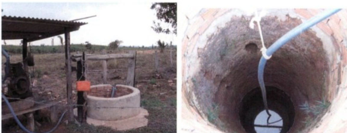
Imagens de poço sem qualquer vedação utilizado para coleta de água para consumo humano, em ângulo aberto e em detalhe
