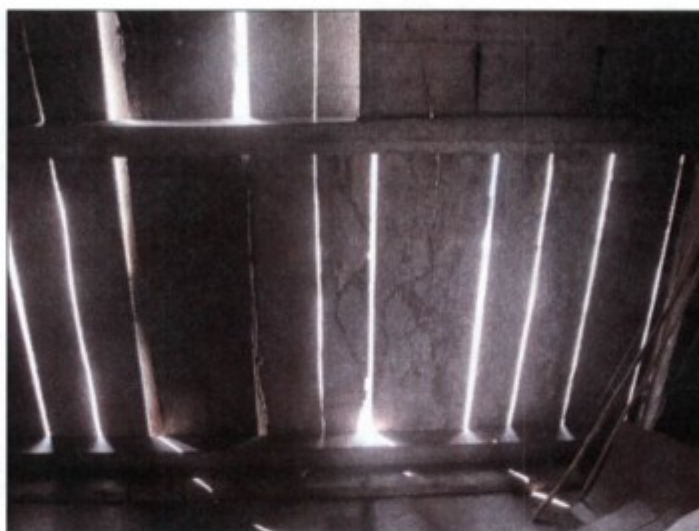
parte interna de um alojamento - sem vedação adequada
