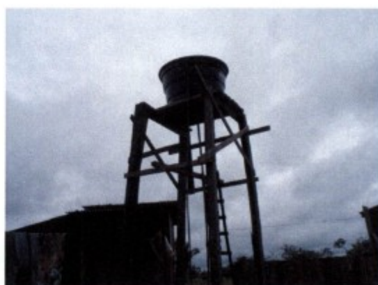
Caixa d'água onde era acondicionada a água proveniente do córrego para distribuição nas moradias e nas instalações sanitárias.
