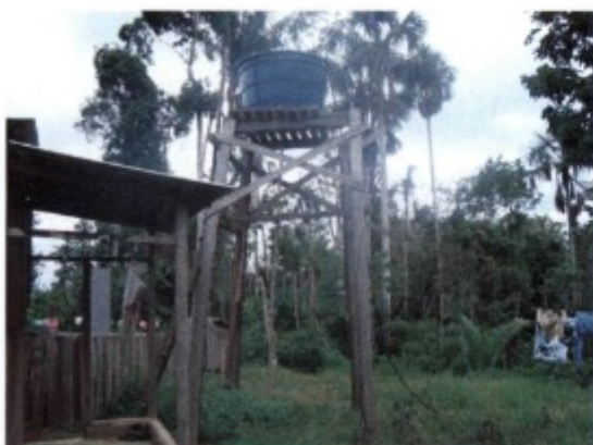
Caixa d'água onde era acondicionada a água proveniente do córrego para distribuição nas moradias e nas instalações sanitárias.
