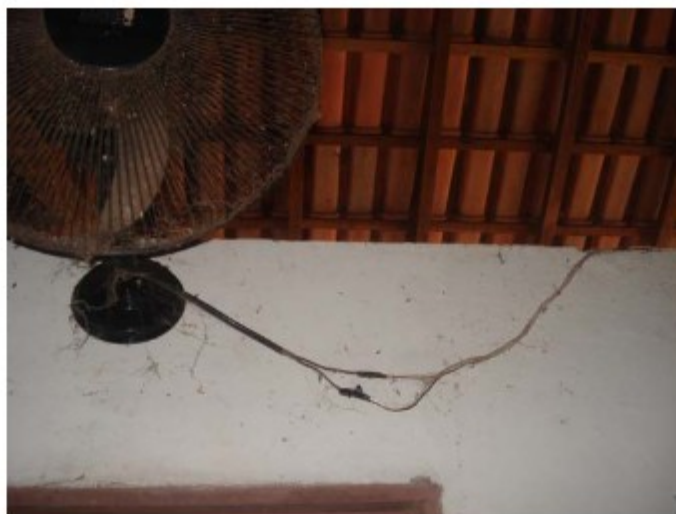
Problemas nas instalações elétricas.
