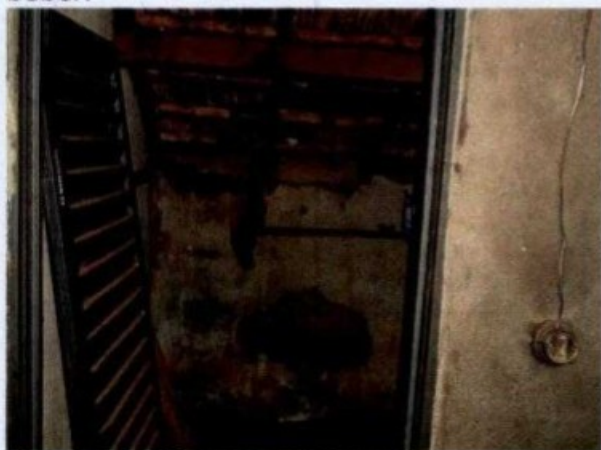
Porta da instalação sanitária solta e o lodo nas paredes
