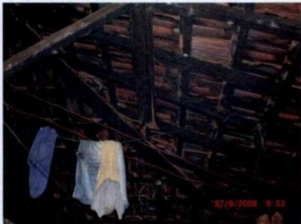
Fiação elétrica sem fixação e tomada solta
