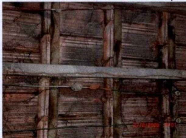
Cupins por toda madeira e paredes rachadas
