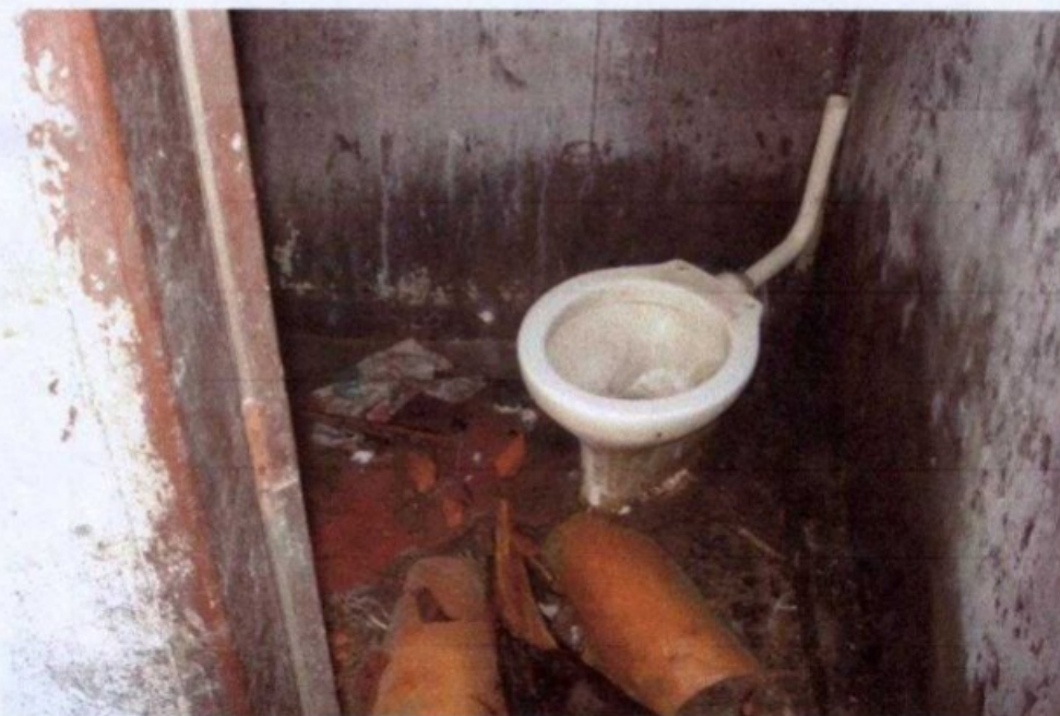
Foto 6 – Instalação sanitária do segundo alojamento, constituída apenas de vaso sanitário sem descarga, e chuveiro (sem lavatório), em precárias condições de conservação e limpeza.
