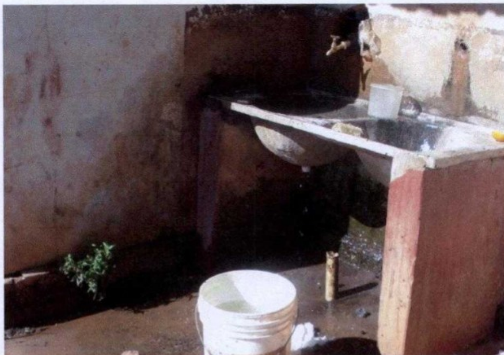
Foto 7 – Área de serviço do segundo alojamento, cujo tanque era também utilizado como pia e lavatório. A água servida era escoada para a própria área de serviço.
