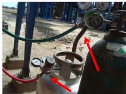
Os equipamentos de solda não atendiam a legislação, pois não apresentavam mecanismos contra retrocesso de chamas, na saída dos cilindros e chegada no maçarico.
