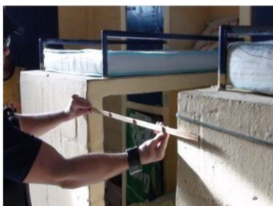
Detalhe do espaçamento de 58 cm entre as camas do alojamento "Cordantas". Essa irregularidade prejudicava as condições de conforto oferecidas aos trabalhadores, causando desconforto térmico e prejudicando a circulação dos obreiros nos "quartos".
