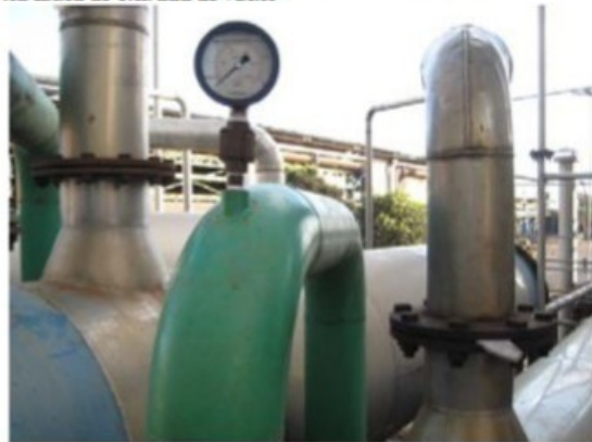
A direita: Manômetro com válvula de segurança instalado no lado casco dos condensadores. À esquerda: Manômetro instalado na linha de água dos condensadores
