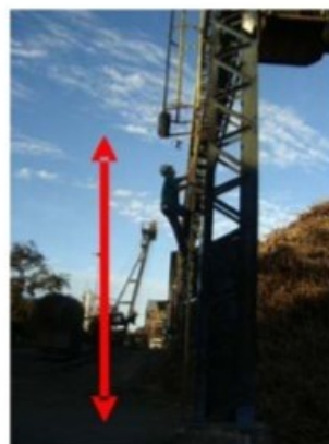
A direita e no centro: Locais da ponte rolante sem guarda-corpo, sem rodapé e com risco de esmagamento de trabalhadores. A esquerda: detalhe de escada, sem proteção, a ceca de 5 (cinco) metros de altura.
