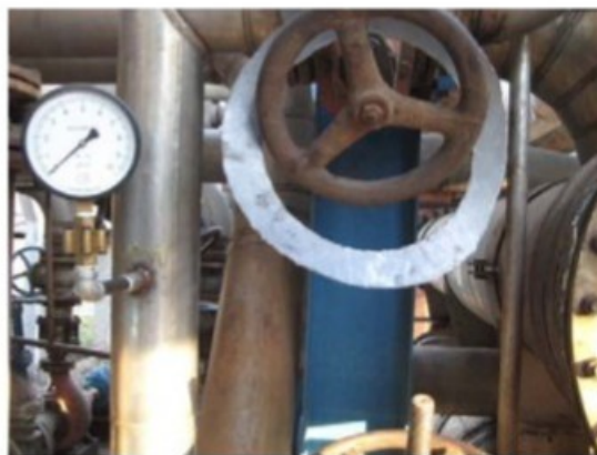
Manômetro instalado na linha de entrada de vinho
