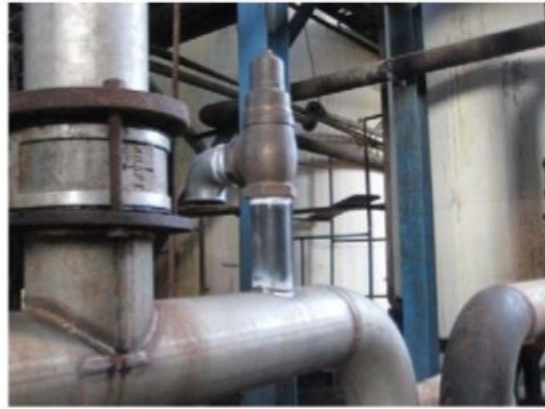
Válvula de segurança instalada na linha de entrada de vinho
