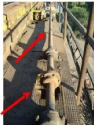
O piso da ponte rolante encontrava-se com sérios problemas com buracos e corrosão.
