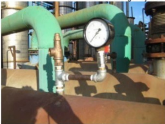
A direita: Manômetro com válvula de segurança instalado no lado casco dos condensadores. À esquerda: Manômetro instalado na linha de água dos condensadores
