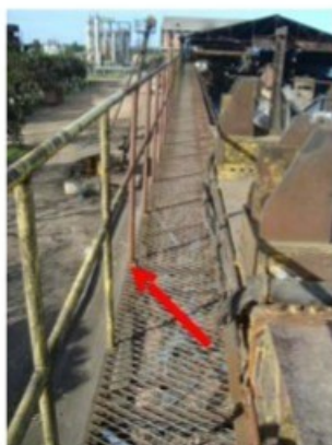
A direita e no centro: Locais da ponte rolante sem guarda-corpo, sem rodapé e com risco de esmagamento de trabalhadores. A esquerda: detalhe de escada, sem proteção, a ceca de 5 (cinco) metros de altura.
