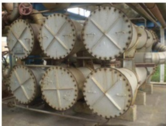
Foto exemplificativa de aquecedores encontrados na situação supramencionada, dentre os inúmeros equipamentos irregulares encontrados no setor de destilaria
