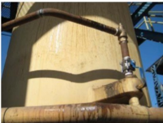
Válvula de alívio instalada na calandra do regenerador
