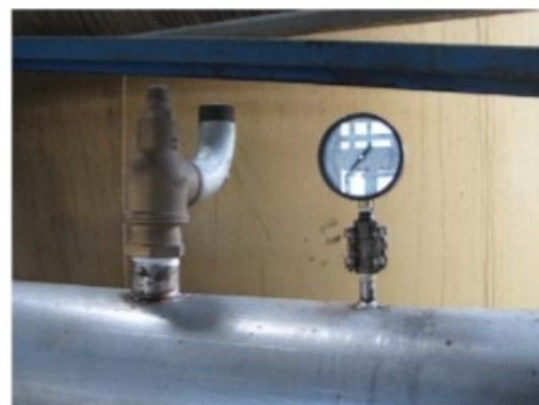
Válvula de segurança e manômetro instalado na linha de vinho
