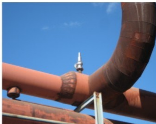
Válvula de segurança instalada na linha do vegetal
