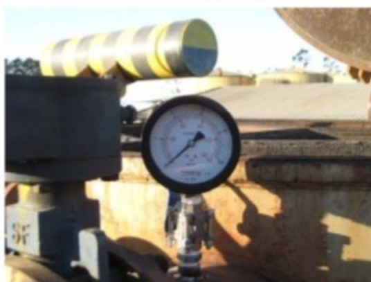
Manômetros instalados no corpo e calandra do aquecedor
