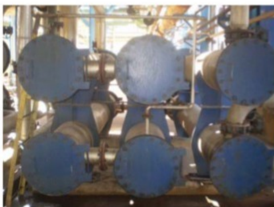
Detalhe dos trocadores de calor, localizados na destilaria que, na mesma forma, não apresentavam mesmos requisitos mínimos
