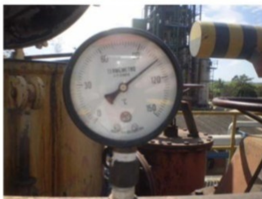
A esquerda: Parte superior da bateria de vasos de pressões identificadas nas fotos acima. A direita: Detalhe do termômetro analógico indicativo de temperatura no interior do sistema.
