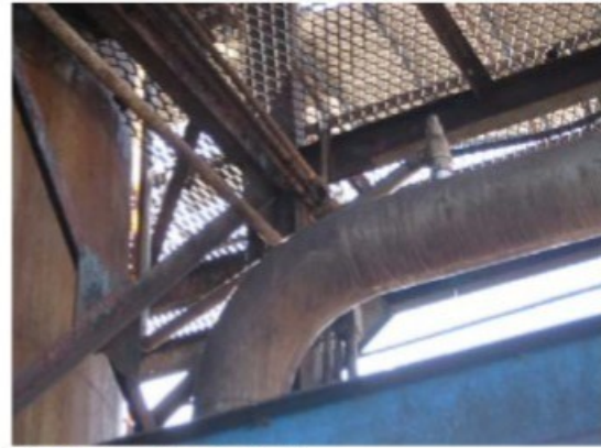
Válvula de segurança instalada na tubulação de recalque das bombas
