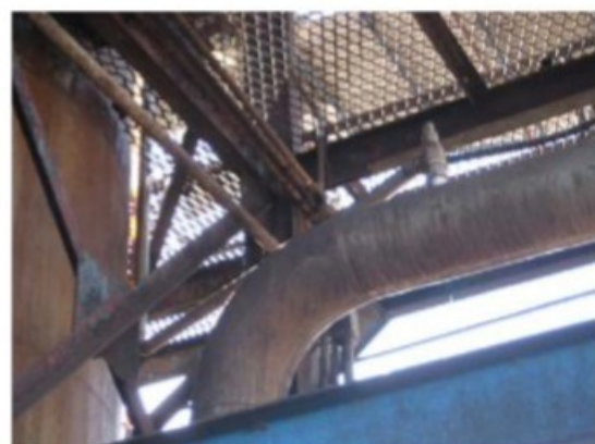
Válvula de segurança instalada na tubulação de recalque das bombas
