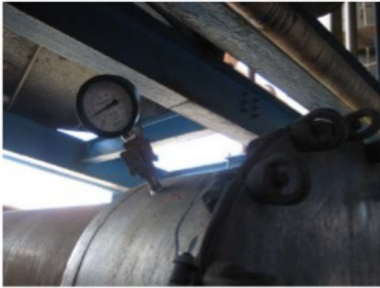
Manômetro instalado na entrada de vinho
