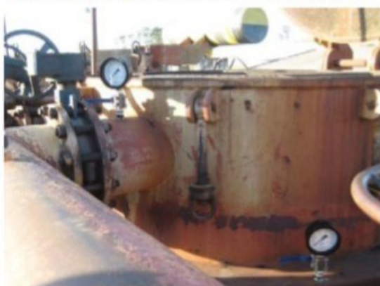
Manômetros instalados no corpo e calandra do aquecedor
