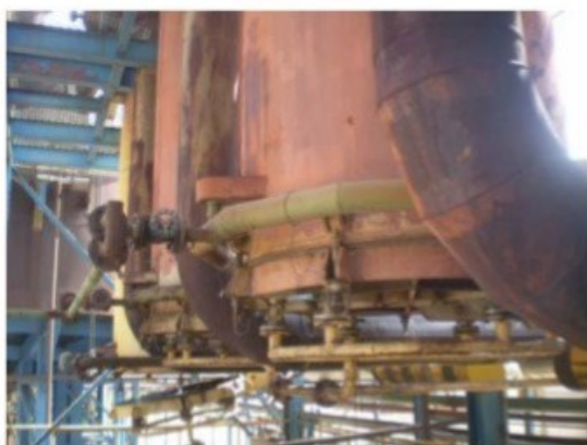
Parte inferior da bateria de 03 (três) aquecedores e 02 (dois) regeneradores, localizados próximos às “decantadeiras, que não possuem quaisquer manômetros e válvulas de segurança, conforme os requisitos mínimos especificados em norma
