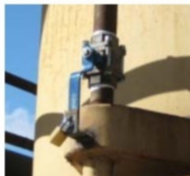
Dispositivo contra bloqueio inadvertido
