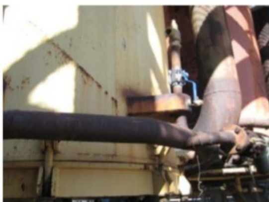
Válvula de segurança instalada na calandra do aquecedor
