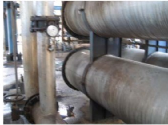
Manômetro instalado na saída de vinhaça
