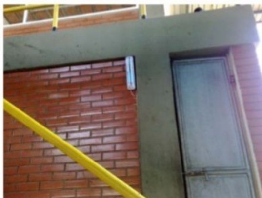
Iluminação emerg. descida da sala de controle
