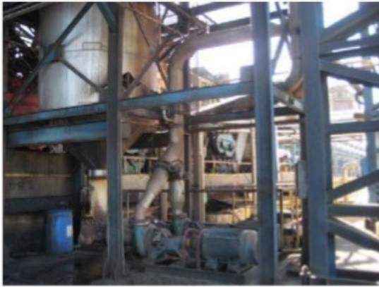
Válvula de segurança instalada na tubulação de recalque das bombas
