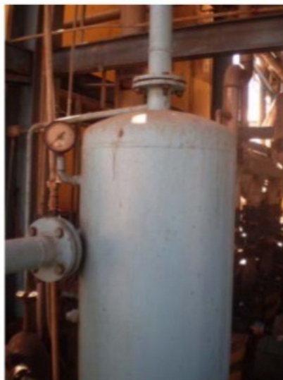
Esquerda: Tanque de transferência de água condensada sem manômetro. Direita: Pulmão da bomba de vácuo sem válvula de segurança e com instalação de manômetro inadequado por não medir a pressão do vácuo
