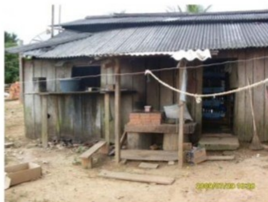
Frestas na parede (esq.). Jirau utilizado para limpeza de utensílios, nos fundos da moradia.
