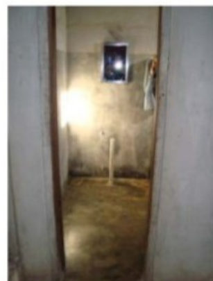
Note-se a falta de encanamento do vaso sanitário, a falta de chuveiro e de lavatório, vez que não havia água corrente no local.
