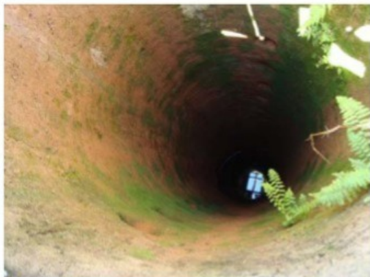
O poço não possuía qualquer revestimento.
