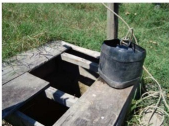
O poço ficava descoberto. A água era coletada em embalagem reaproveitada que contivera óleo para motor.
