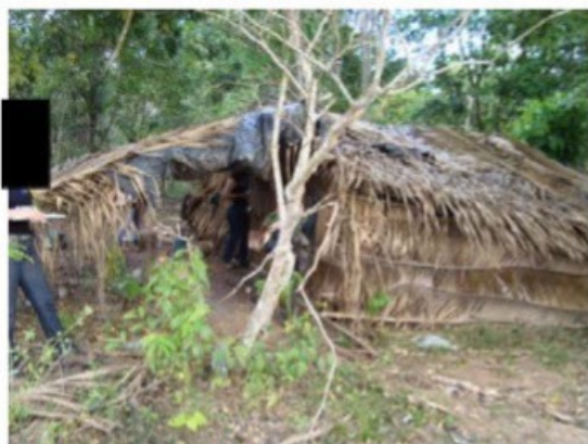
Vista externa da estrutura de madeira com cobertura de lona plástica e palha.
