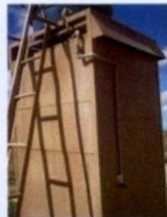
Cabine metálica, levada até as proximidades da extensa área descampada de plantio de cana, no dia 08/07/09, sem água, sem torneira e sem lavatório, sem fixação, simplesmente apoiada sobre tronco de madeira.
