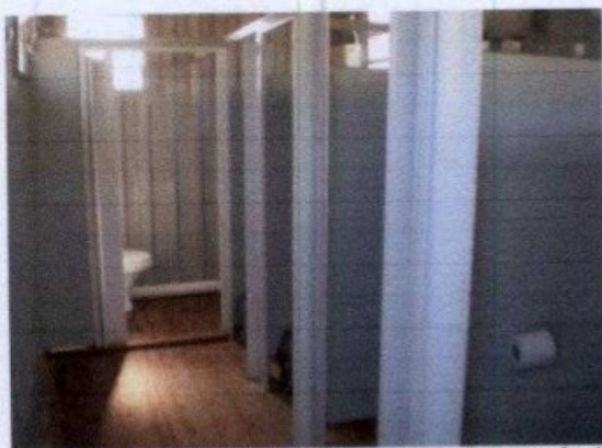
Verificada a aquisição de "containers", modificados para o funcionamento de instalações sanitárias com 05 (cinco) vasos sanitários e dois lavatórios, utilizando sistema de fossa seca, em atendimento as normas de segurança e saúde do trabalho.
