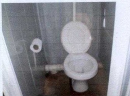
Verificada a aquisição de "containers", modificados para o funcionamento de instalações sanitárias com 05 (cinco) vasos sanitários e dois lavatórios, utilizando sistema de fossa seca, em atendimento as normas de segurança e saúde do trabalho.
