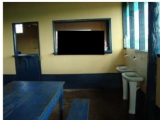
Área interna do local de tomada de refeições com piso refeito, paredes laterais e instalação de lavatórios para higienização.
