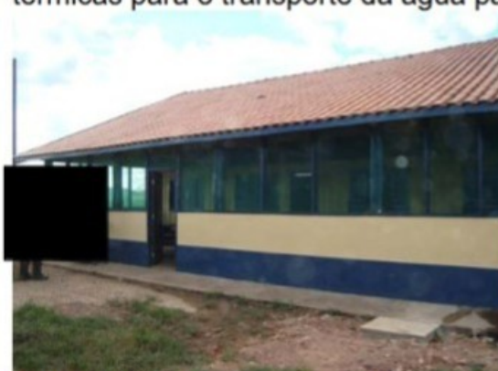
Local para refeições do alojamento "barracão", totalmente reformado. Agora com paredes laterais e telas que permitem iluminação e ventilação e impedem a entrada de insetos.
