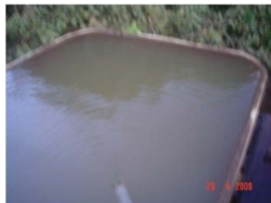
Caixas de água que serviam as moradias localizadas no retiro "Californinha" e que estavam sem a devida proteção.
