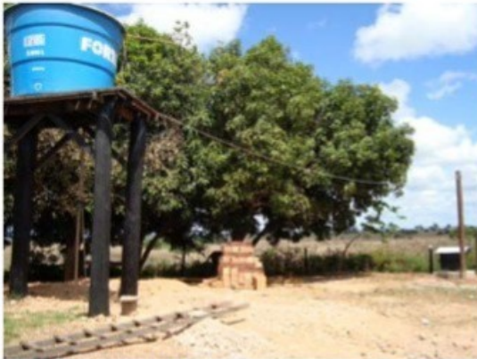
Caixa d'água instalada que juntamente com o poço perfurado e bomba elétrica passaram a compor o sistema de abastecimento de água desse retiro.
