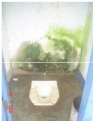
Sanitário do tipo "bacia turca" (esq.), recipiente para lixo sobre caixa de esgotamento sem vedação (meio) e cobertura do acesso desde o alojamento até às instalações sanitárias.
