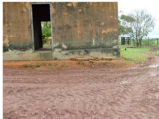
Inspeção nas moradias do retiro "Alabama", onde já podia se verificar o aterramento do terreno que circundava uma das moradias a fim de promover o nivelamento do terreno.
