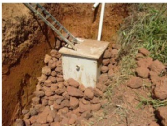
Instalação do sistema de esgoto desde as moradias até a fossa séptica.
