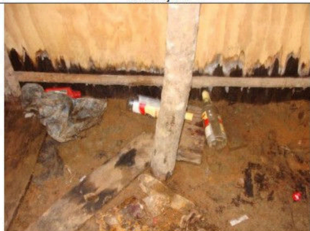
Compensados deteriorados na parte inferior de uma das construções
