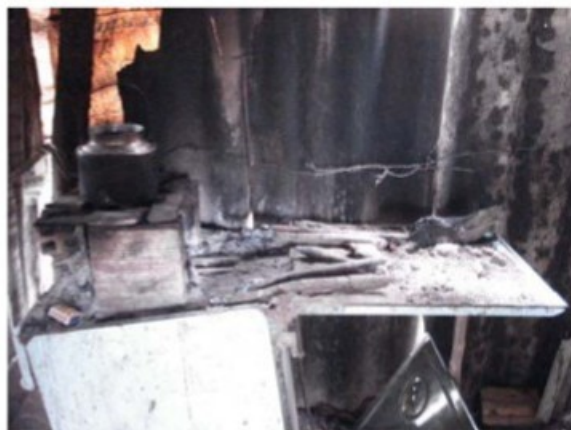
Vista dos fogões improvisados, alimentados à lenha, provocando fumaça, que permanece no ambiente pela insuficiência de ventilação e pela ausência de condutores da fumaça.
