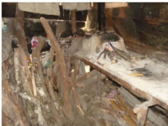
Vista dos fogões improvisados, alimentados à lenha, provocando fumaça, que permanece no ambiente pela insuficiência de ventilação e pela ausência de condutores da fumaça.
