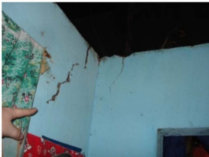
Detalhe da rachadura na parede. E AFT praticamente encosta cabeça na estrutura que sustenta o telhado.
