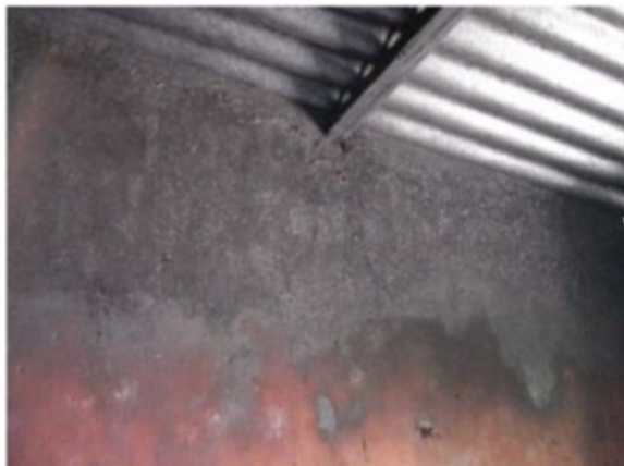
Vista das paredes das moradias. Aspecto escuro que imita ao piche, provocado pela fumaça dos fogões à lenha, sem condutor de fumaça para fora do ambiente.
