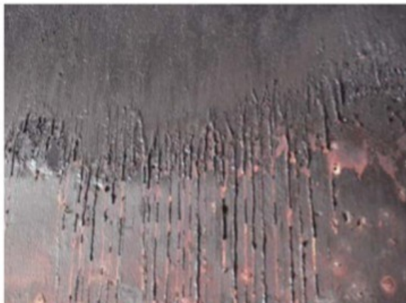
Vista das paredes das moradias. Aspecto escuro que imita ao piche, provocado pela fumaça dos fogões à lenha, sem condutor de fumaça para fora do ambiente.
