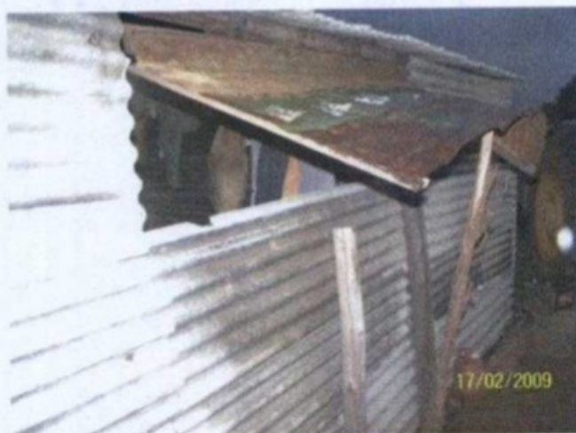
FOTO 21. Havia apenas uma pequena janela basculante improvisada que impedia a adequada ventilação no alojamento.
