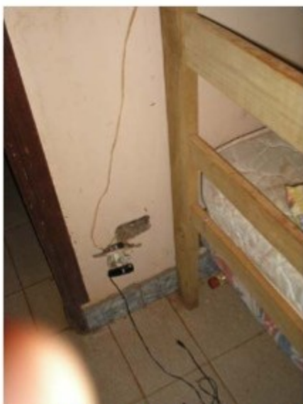
Precárias instalações elétricas determinando o risco de choque elétrico, de curto-circuito e de incêndio.
