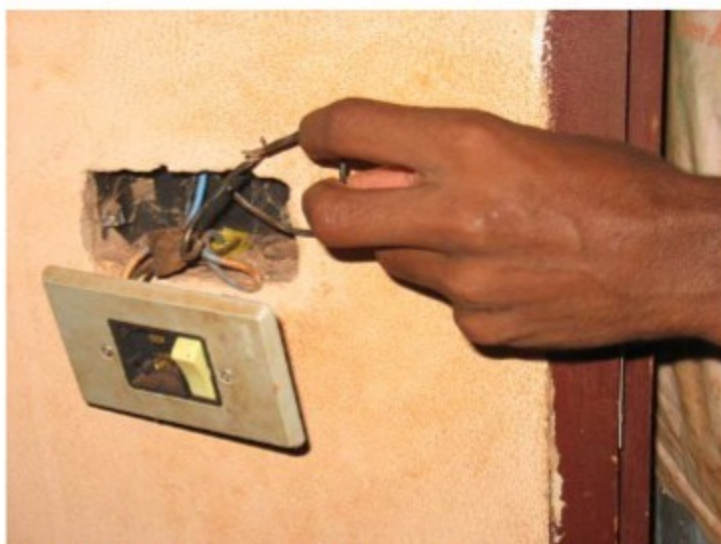
Precárias instalações elétricas determinando o risco de choque elétrico, de curto-circuito e de incêndio.
