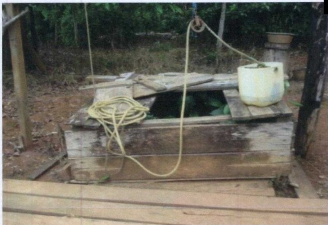
(A água consumida pelos empregados era de poço do tipo amazonas (poço cilíndrico aberto manualmente), cujo líquido apresentava presença de material em suspensão e tinha cor amarelada)
