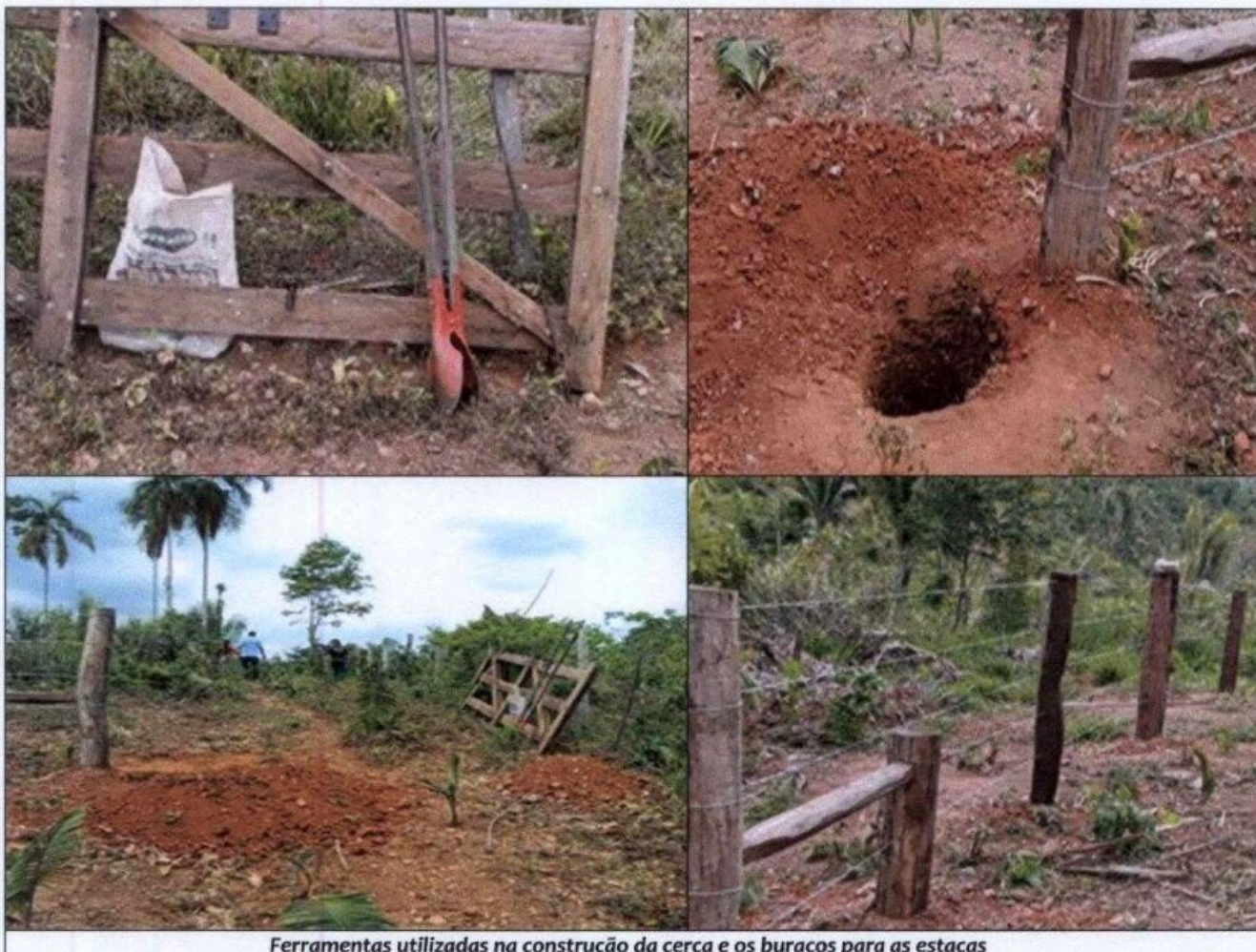
Ferramentas utilizadas na construção da cerca e os buracos para as estacas
