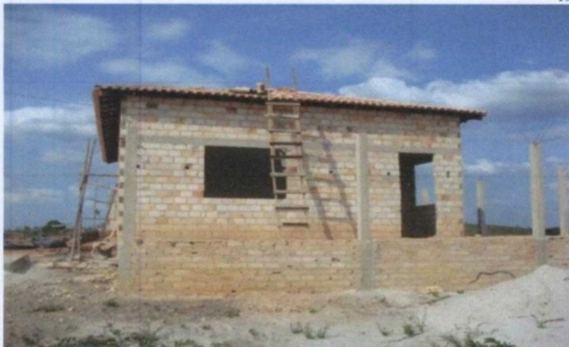
02- Obra contendo 03 compartimentos, com banheiro interno e varanda em L, com cobertura parcial de telha de barro, sem piso, sem reboco, sem portas e janelas, sem aparelhos sanitários instalados e sem a estrutura elétrica e hidráulica.
