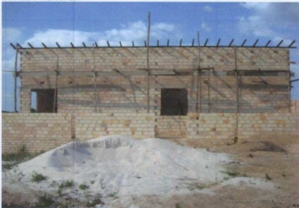
03- Obra contendo 04 compartimentos, com banheiro externo e varanda frontal, sem cobertura, sem piso, sem reboco, sem portas e janelas, sem aparelhos sanitários instalados e sem a estrutura elétrica e hidráulica.
