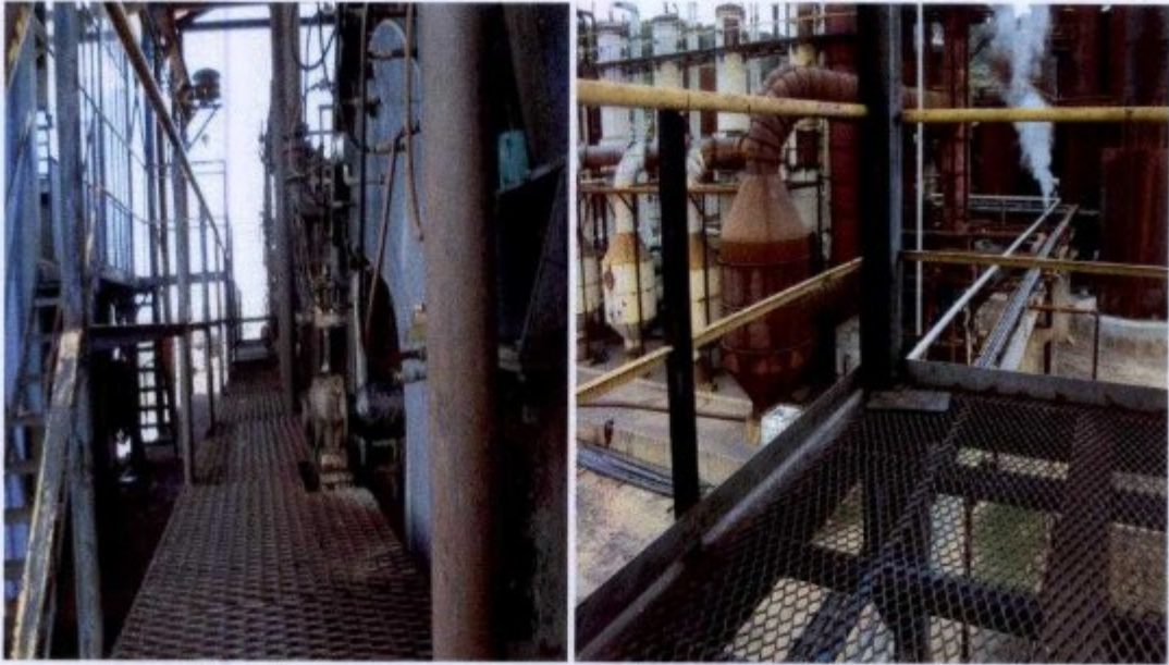
Instalação de rodapés nos pavimentos superiores
