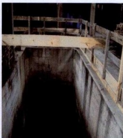
Cercamento de abertura do piso no segundo pavimento da edificação, onde se encontra a lavadora desativada
