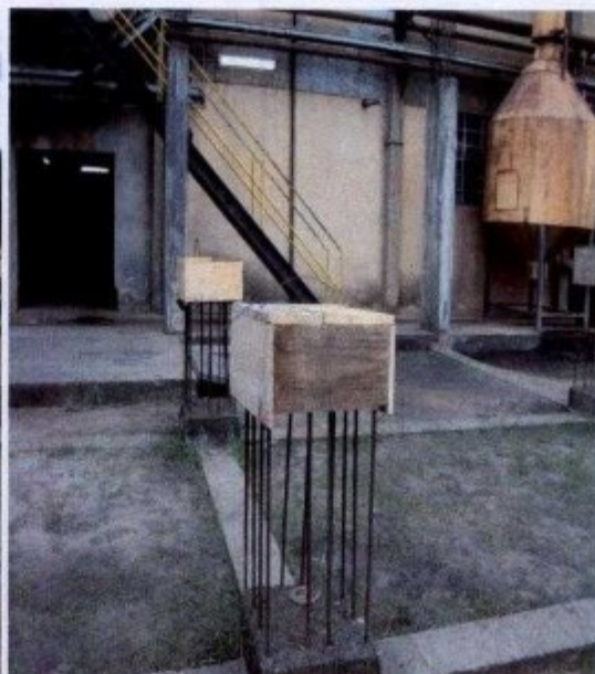
Proteção das pontas dos vergalhões expostos
