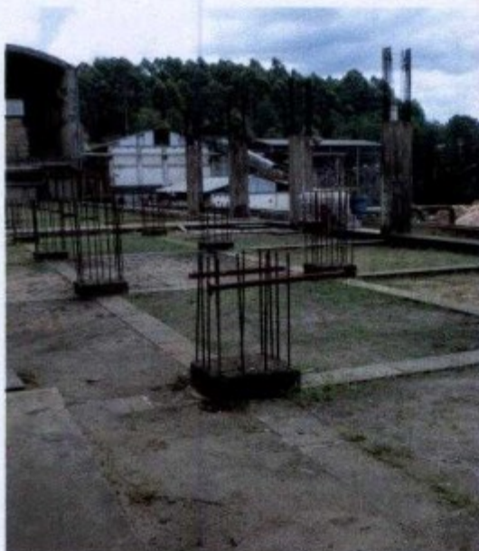
Proteção das pontas dos vergalhões expostos
