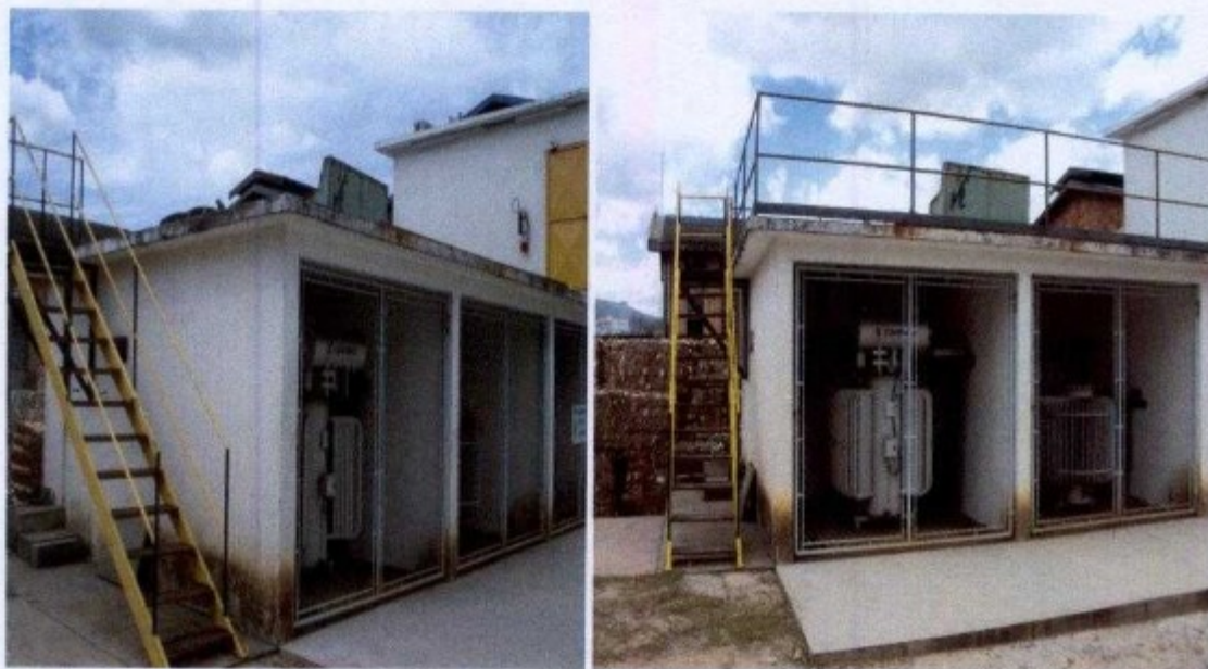
Instalação na escada de proteções tipo guarda-corpo
