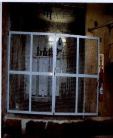
Isolamento do transformador de energia
