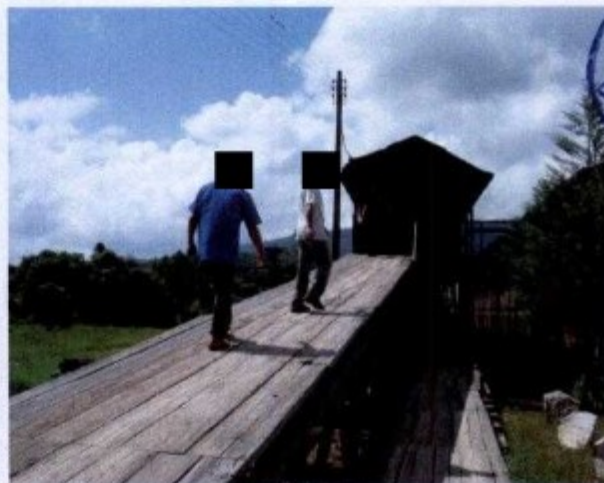
fotos: rampa de acesso à área de secagem, sem guarda corpo
