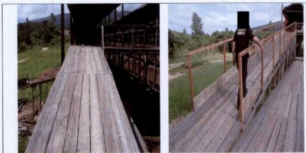
Instalação de corrimão na rampa de acesso ao guincho de arraste
