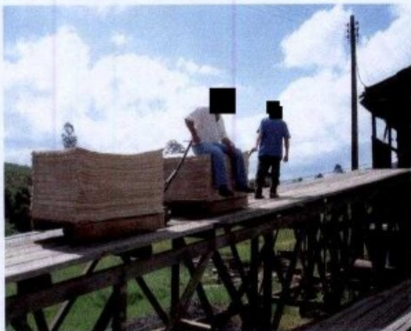
fotos: rampa de acesso à área de secagem, sem guarda corpo
