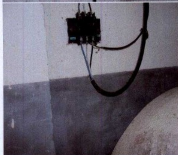
fotos: instalações elétricas com partes vivas expostas e ligações improvisadas
