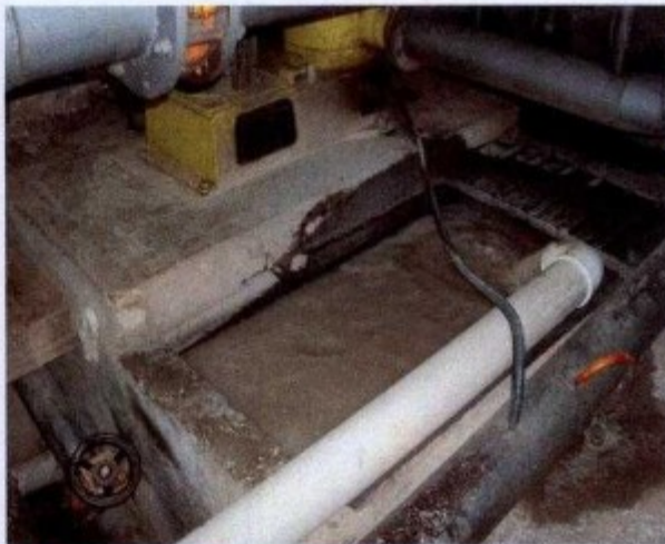
fotos: áreas de preparação da polpa da madeira com aberturas no piso
