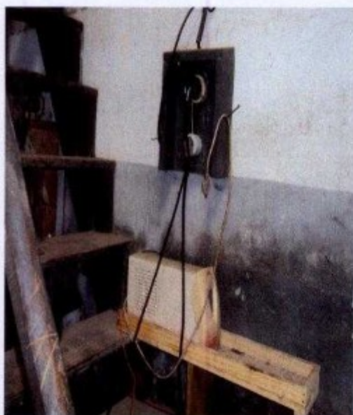
fotos: instalações elétricas com partes vivas expostas e ligações improvisadas
