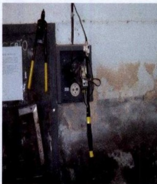
fotos: instalações elétricas com partes vivas expostas e ligações improvisadas
