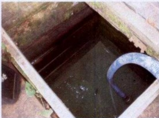
Cacimba (e motor) de onde é distribuída a água para a casa sede.
