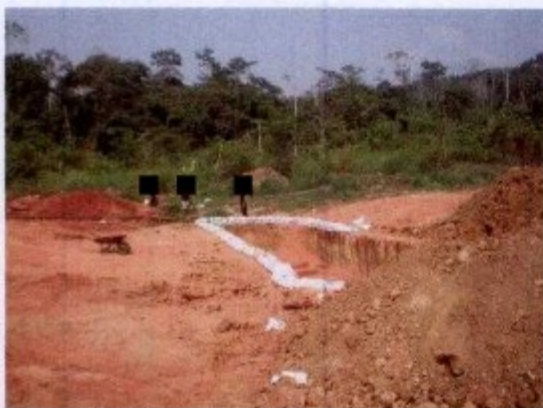
Escavação do "tanque de cianeto".
