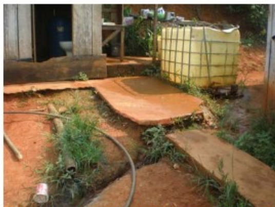
Escoamento, a céu aberto, das águas usadas do local de limpeza de utensílios e do cubículo utilizado como instalação sanitária.
