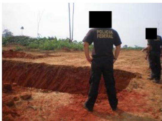
Escavação do "tanque de carvão" (as caixas com carvão para filtragem são colocadas à beira do tanque).
