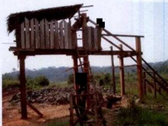
Local onde a vagoneta despejava pedras, sem qualquer proteção contra a queda das pedras.
