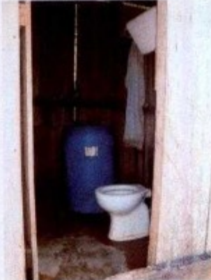
Cubículo utilizado à guisa de instalação sanitária, contíguo ao local onde se lavavam os utensílios de cozinha. Note-se que o vaso sanitário não está ligado a instalação alguma.
