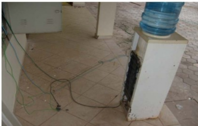
Foto 5: Gambiarra na ligação elétrica do bebedouro.
