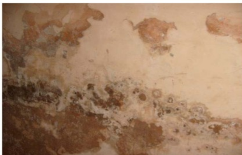
Foto 32: Mofo e umidade nas paredes.
