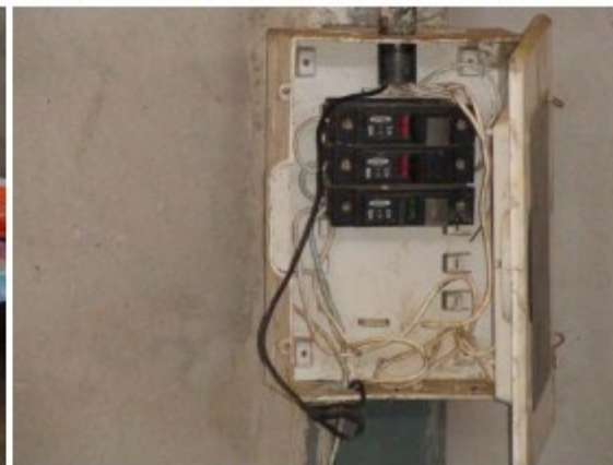
Auditor entrevista trabalhadora ao lado de uma criança. Quadro de disjuntores sem proteção.
