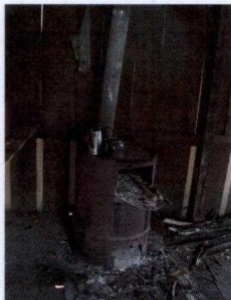
Fogão feito com tonel e alimentado com lenha. Veja no detalhe a quantidade de carvão e ou restos de lenha caída na frente do fogão, com risco de incêndio.
