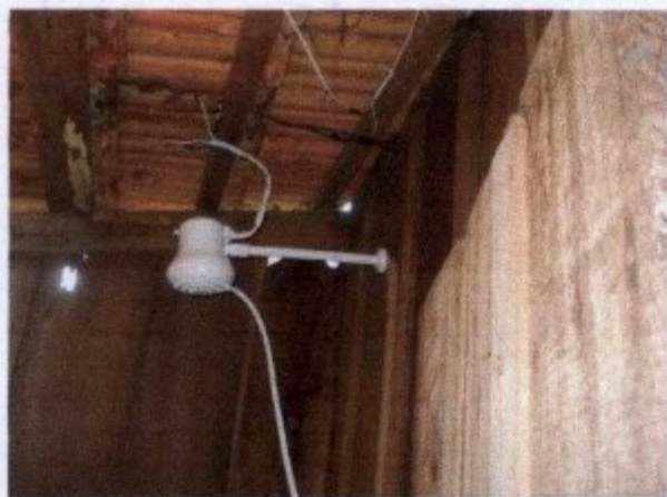
Vista do chuveiro e no detalhe a ligação elétrica sem isolamento.
