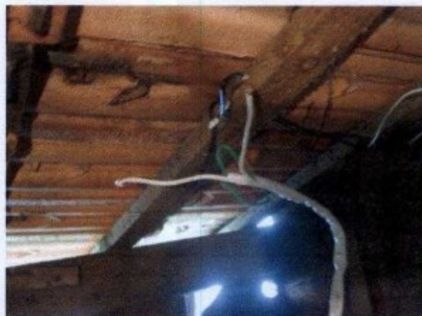
Vista do chuveiro e no detalhe a ligação elétrica sem isolamento.
