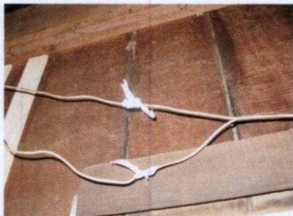
Ligação de fios elétricos feito com sacolas plásticas.
