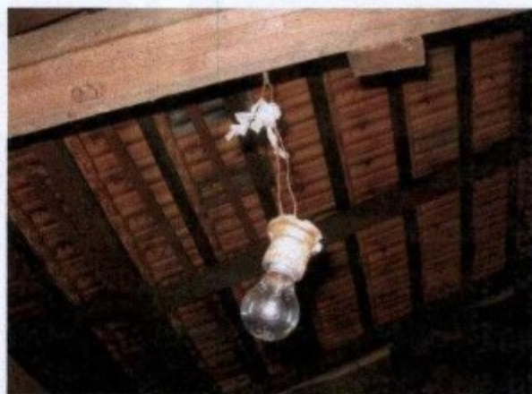
Ligação de fios elétricos feito com sacolas plásticas.
