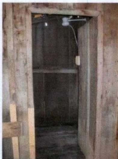
Vista da instalação do chuveiro, com a tesoura servindo de apoio para o registro.
