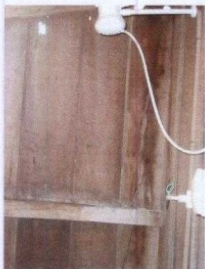
Vista da instalação do chuveiro, com a tesoura servindo de apoio para o registro.
