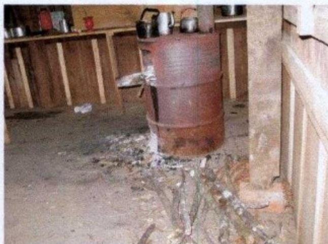
Fogão feito com tonel e alimentado com lenha. Veja no detalhe a quantidade de carvão e ou restos de lenha caída na frente do fogão, com risco de incêndio.
