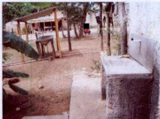
Note-se a cobertura do tanque (ao fundo) com inclinação contrária ao local onde permanece a pessoa que o utiliza que, além do mais, fica descoberta, vez que não há a necessária expansão da cobertura.
