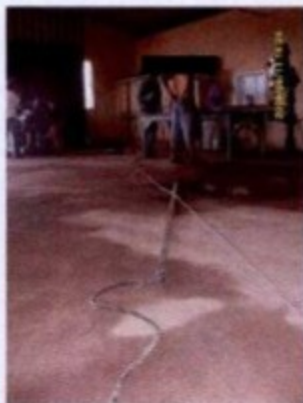
Operações de soldagem sem utilização de anteparo. (note-se a fiação exposta no chão molhado).
