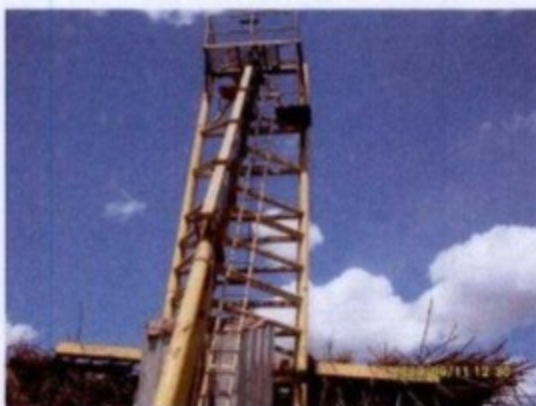
Escada sem proteção no Hilo.
