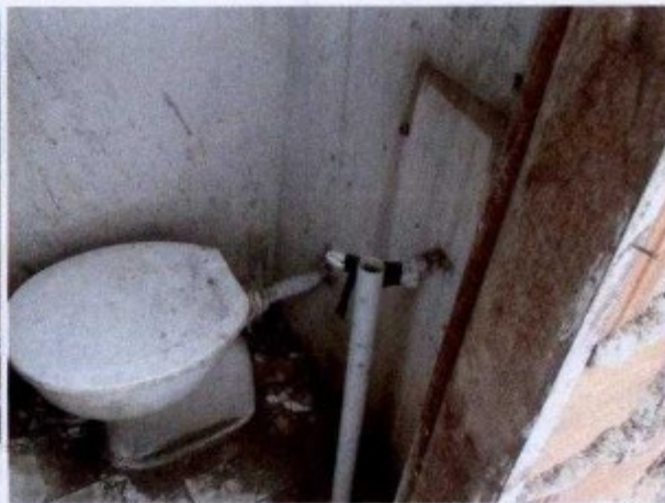
O que sobrou da instalação sanitária. Existe o vaso mas a descarga não funciona
