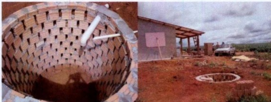
Fossa séptica sendo construída.
