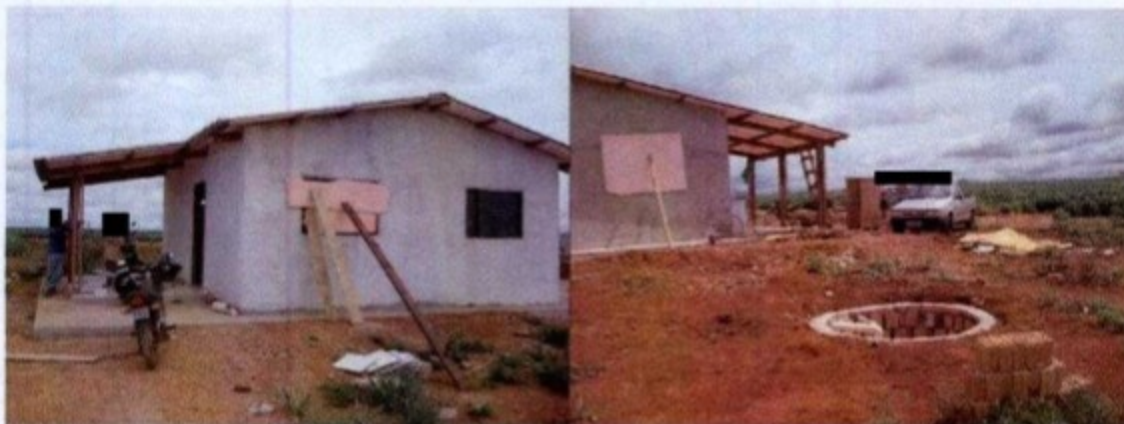
Janelas sem vidros protegidas por material isolante e escorada.
