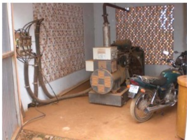
Instalações elétricas desprotegidas.
