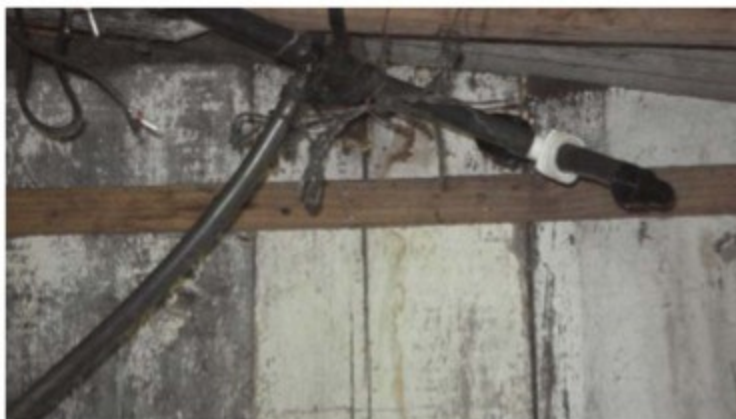
Fios da instalação elétrica de um "chuveiro" utilizado em uma das moradias.
