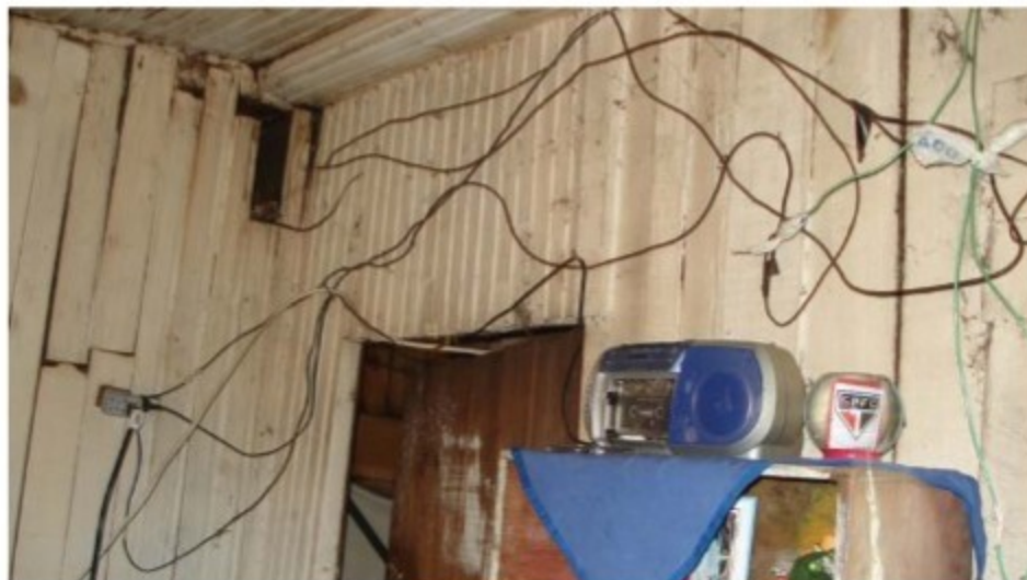
Instalações elétricas com fios amarrados com pedaços de embalagens plásticas.
