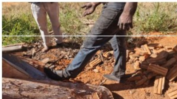
Figura 2 trabalhador sem qualquer equipamento de proteção individual disponibilizado
