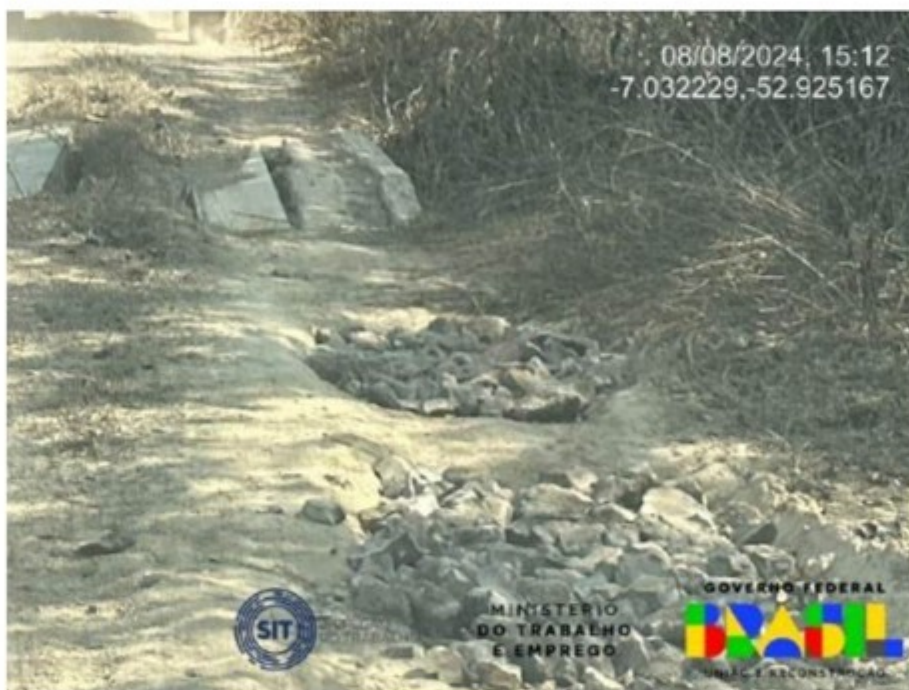
Foto: Pedras colocadas em buracos da estrada de acesso à sede e às áreas de vivência da propriedade rural.
