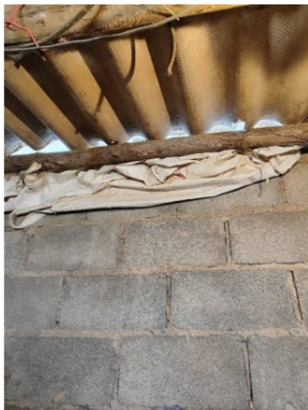
Foto: medida paliativa adotada pelos empregados para amenizar o frio dentro da edificação do alojamento – um saco de café encaixado na fresta entre a parede e o telhado do dormitório.
