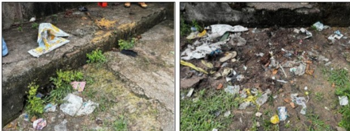
Imagens acima: Lixo e fezes espalhados entre a porta dos fundos do alojamento e a entrada da instalação sanitária.
