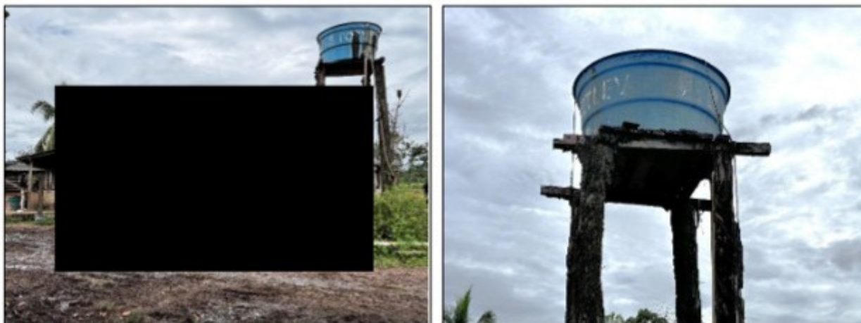
Imagens acima: Caixa onde era armazenada a água retirada do poço. A plataforma de madeira estava corroída por cupins e apresentava risco de desabamento.
