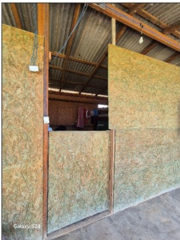
Imagens acima: Porta incompleta e aberturas entre o telhado e as paredes do alojamento de madeira que era utilizado pela maioria dos trabalhadores da Fazenda.
