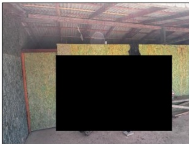
Imagens acima: Porta incompleta e aberturas entre o telhado e as paredes do alojamento de madeira que era utilizado pela maioria dos trabalhadores da Fazenda.
