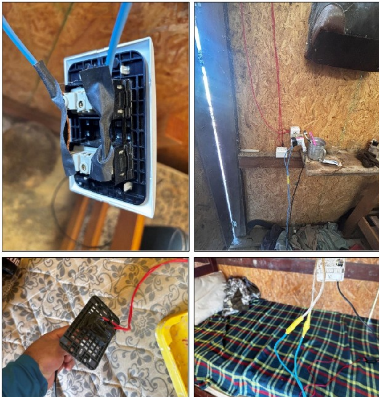
Imagens acima: Instalações elétricas do alojamento de madeira que era utilizado pela maioria dos trabalhadores da Fazenda.
