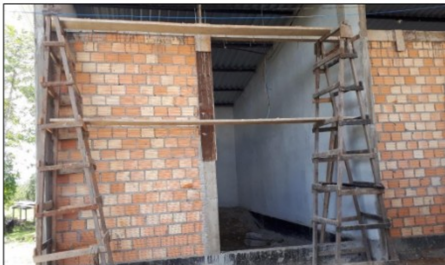
Imagem acima: Andaime de madeira que estava sendo utilizado na obra.
