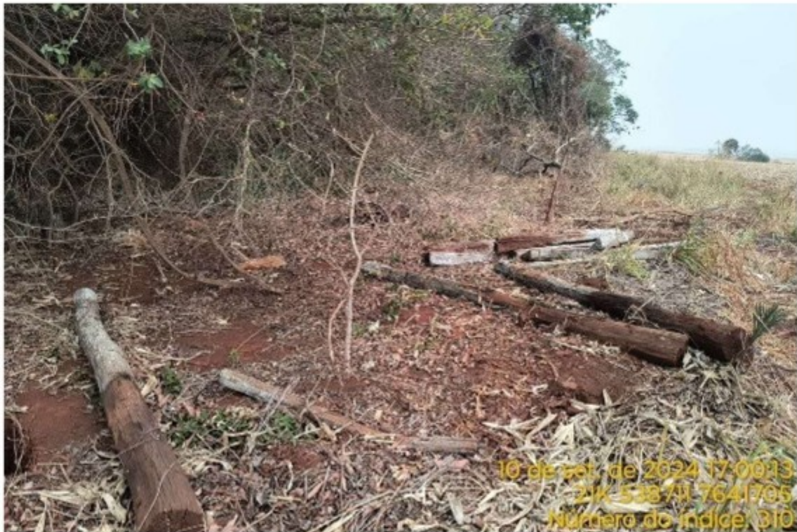
Imagem 16: Frente de Trabalho de Desmanche de Cercas Velhas
