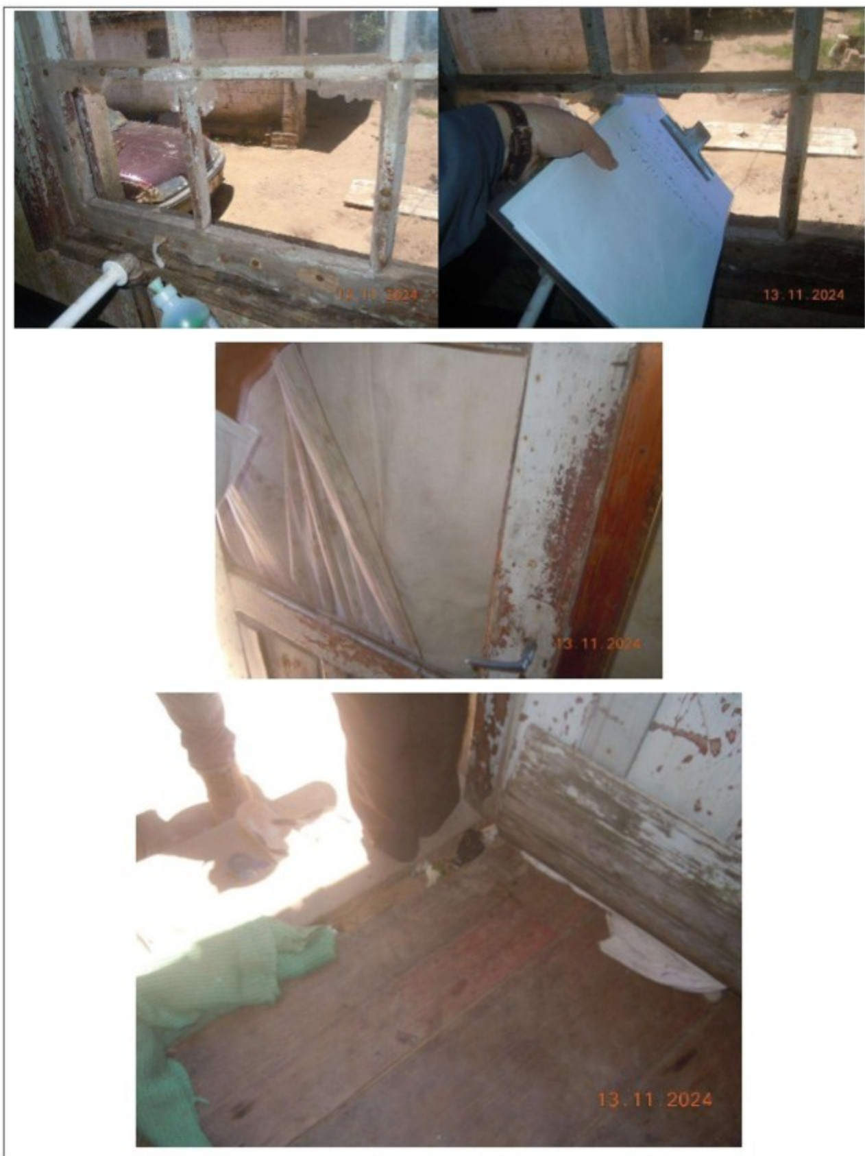
Figura 9 – Janelas sem vidros e/ou quebrados e frestas fechadas com tecidos na parte inferior de porta
