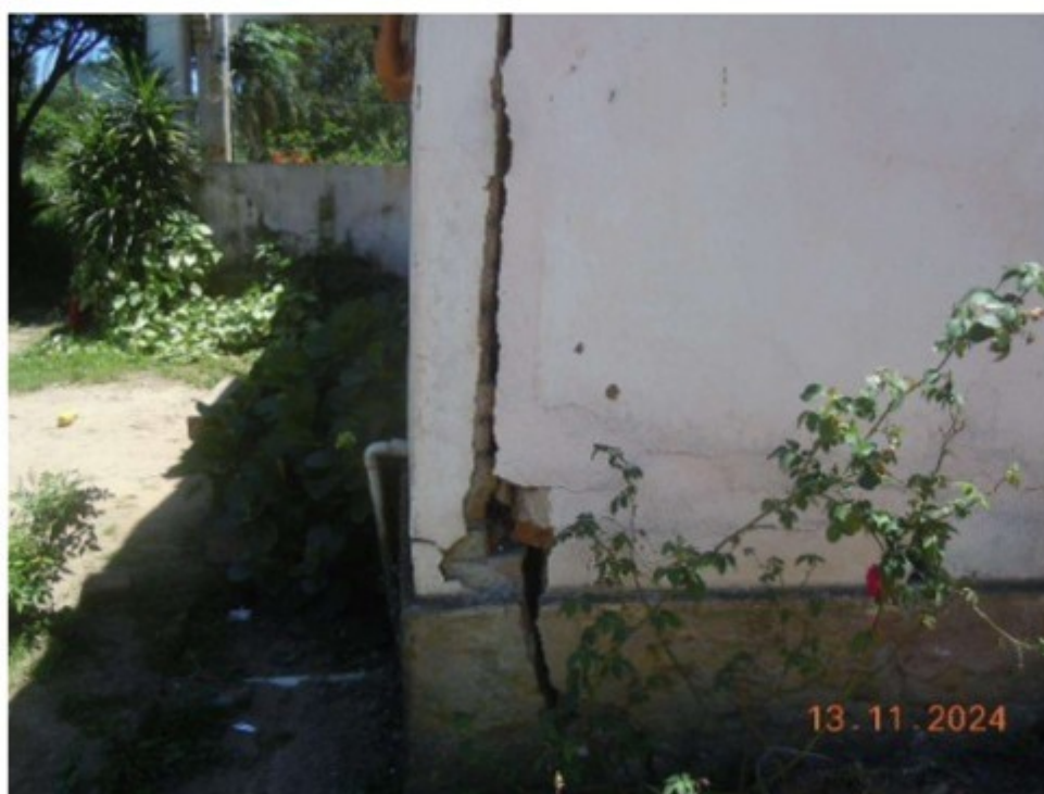
Figura 8 – Rachadura na estrutura da moradia
