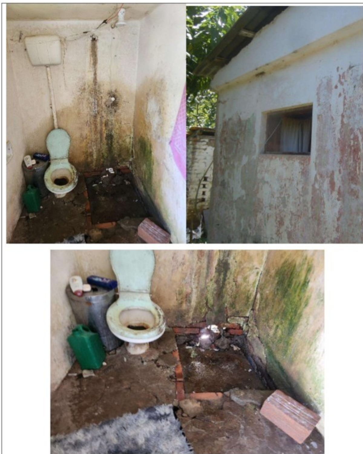
Figura 10 – Banheiro da residência (muito sujeira impregnada, vaso sanitário inclinado, piso quebrado que não permite a higienização, abertura/janela sem esquadria, que não garante a privacidade)
