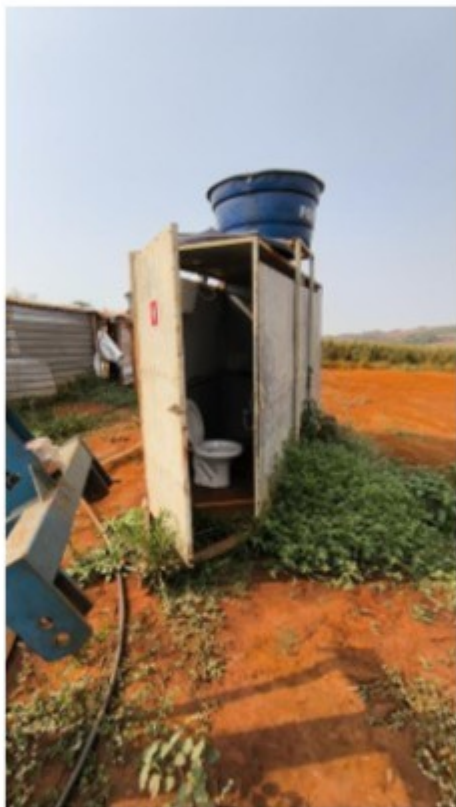
Figura 8 – Instalação sanitária da frente de trabalho inspecionada.
