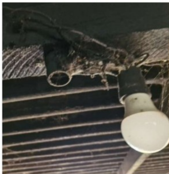
Figura 13 fiação de lâmpada fora de eletrodutos e com partes vivas em contato com a madeira
