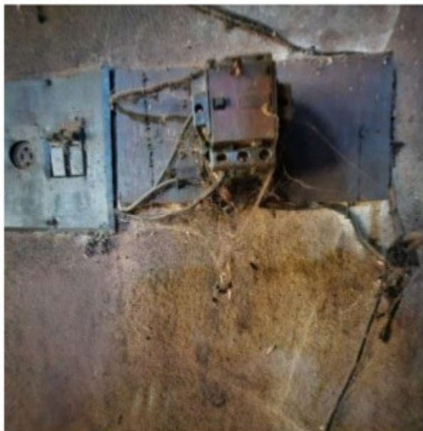
Figura 12 disjuntor com partes vivas expostas e fiação mal remendada
