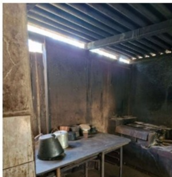
Figura 11 frestas entre a parede e estrutura de cobertura
