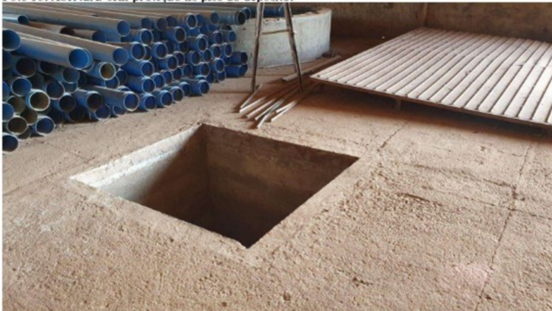
Foto 16: Abertura sem proteção no piso do depósito.
