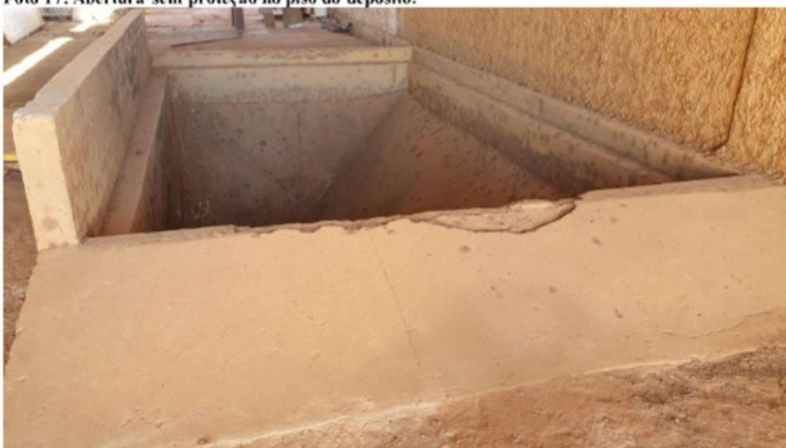
Foto 17: Abertura sem proteção no piso do depósito.
