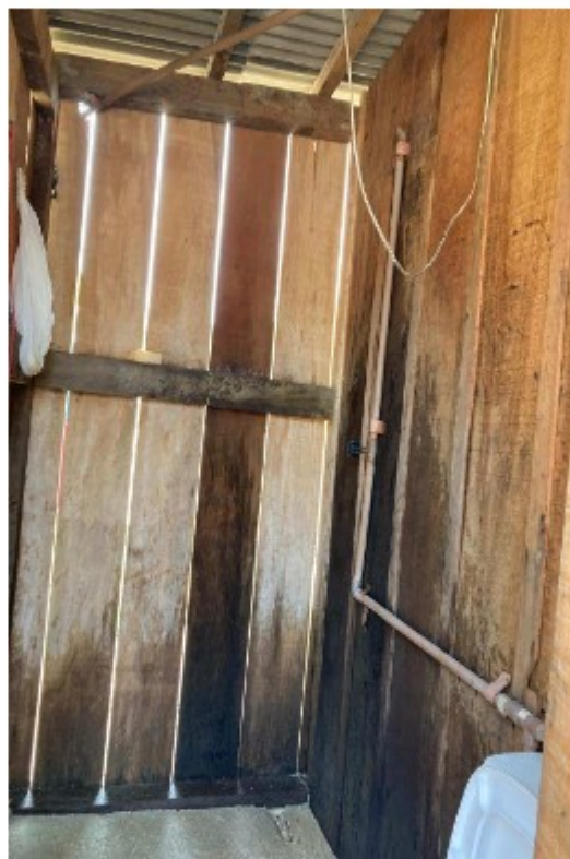
Interior do banheiro. Observar que não havia chuveiro, mas apenas uma ponta de cano por onde saía a água.
